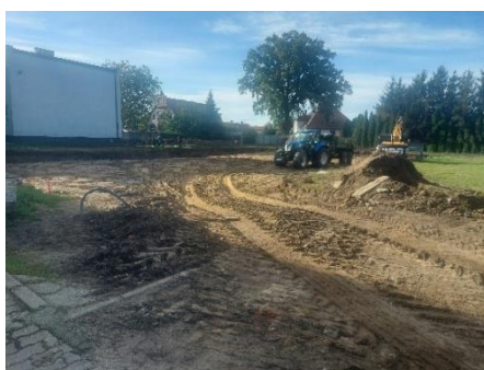
Fot. Gmina Lipno
